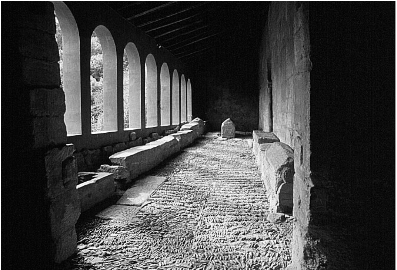
Fig. 4. Pórtico de acceso al Monasterio de Suso, San Millán de la Cogolla.
